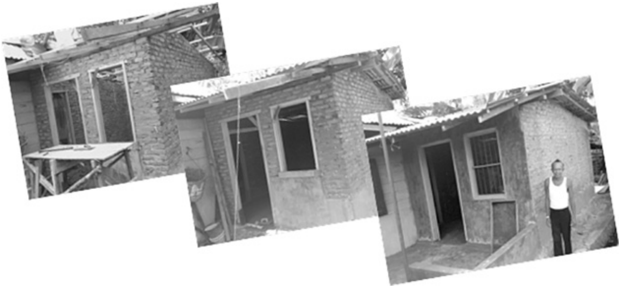
Gambar 4. Prototype Rumah Aman Gempa Hasil Praktek Tukang.
