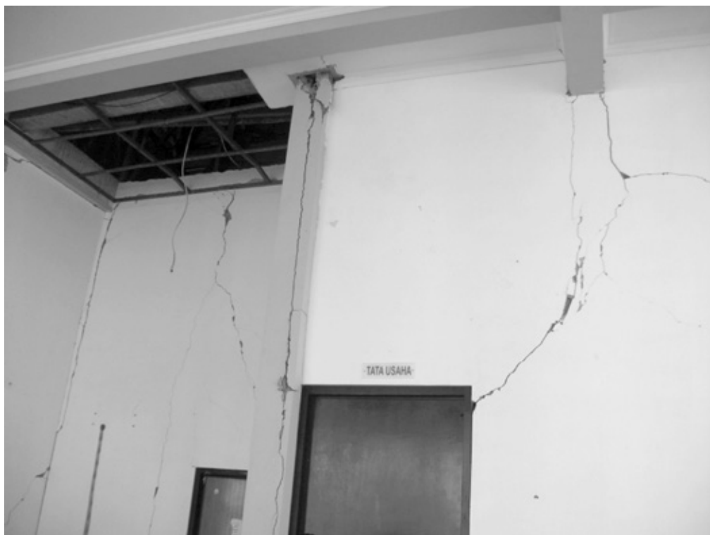
Gambar 8. Kerusakan pada Kolom Praktis Kantor Pelabuhan Penyeberangan Daerah Juata, Akibat Kejadian Gempabumi 21 Desember 2015. Sumber: Supartoyo Dkk., 2016.
