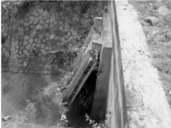
Gambar 7. Pintu-pintu Air Penghubung dengan Sungai Lama.
