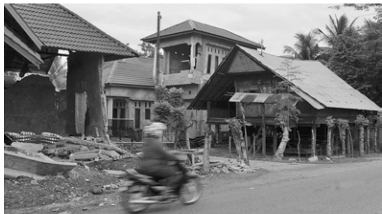
Gambar 1. Rumoh Aceh yang Selamat dari Gempa Pidie di antara Rumah-rumah Bata yang Hancur.
