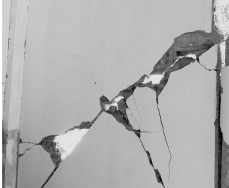
Gambar 7. Kerusakan pada Dinding Masjid Al-Iman.
