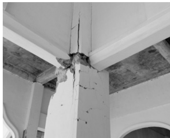
Gambar 6. Kerusakan pada Sambungan Balok Kolom.
